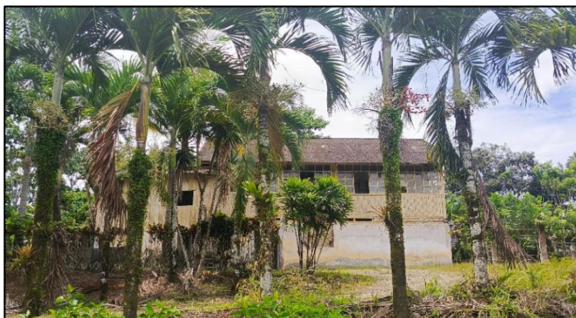
Figura 46: Casa de dos pisos de construcción mixta
