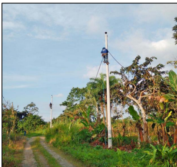
Figura 47: Instalación de Servicio de Energía Eléctrica.
