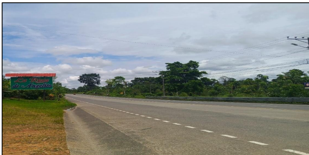
Figura 48: Estado de la Vía E20.
