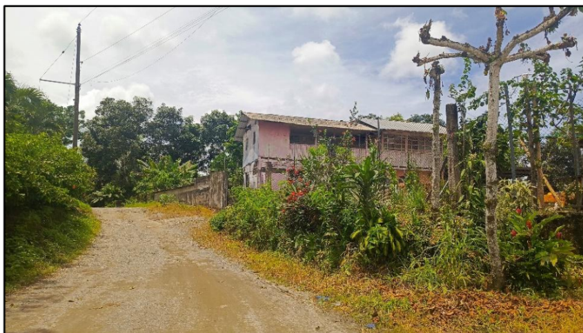
Figura 45: Casa de dos pisos de construcción mixta.
