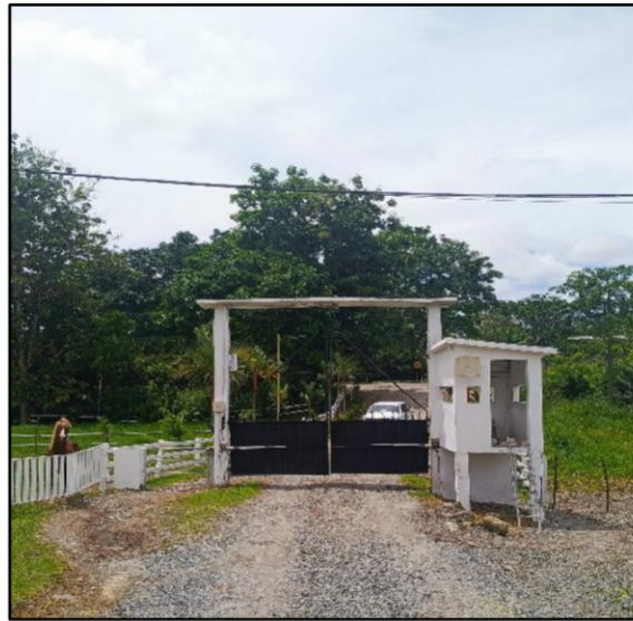
Figura 10: Garita de Seguridad de Fusakatan Cía. Ltda.
