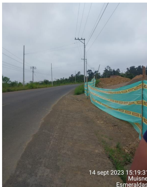
Foto No.2 Lugar de construcción de la estación de servicio Piedra Fina.
