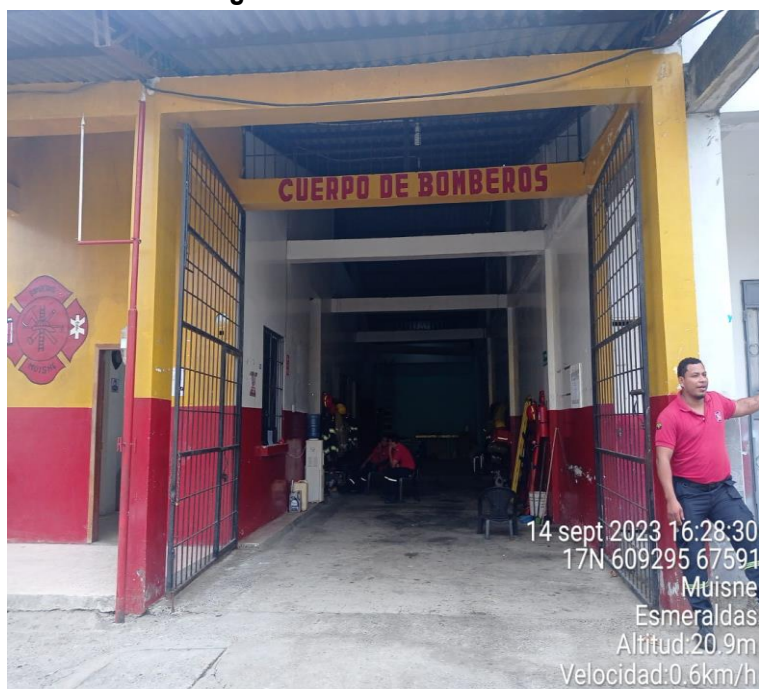
Figura 27. Estación de Bomberos
