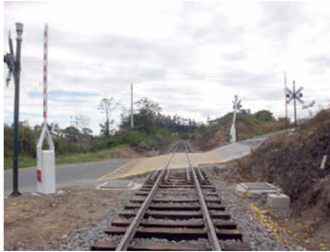
Foto 11 Sistema Integral de señalización Ferroviaria
