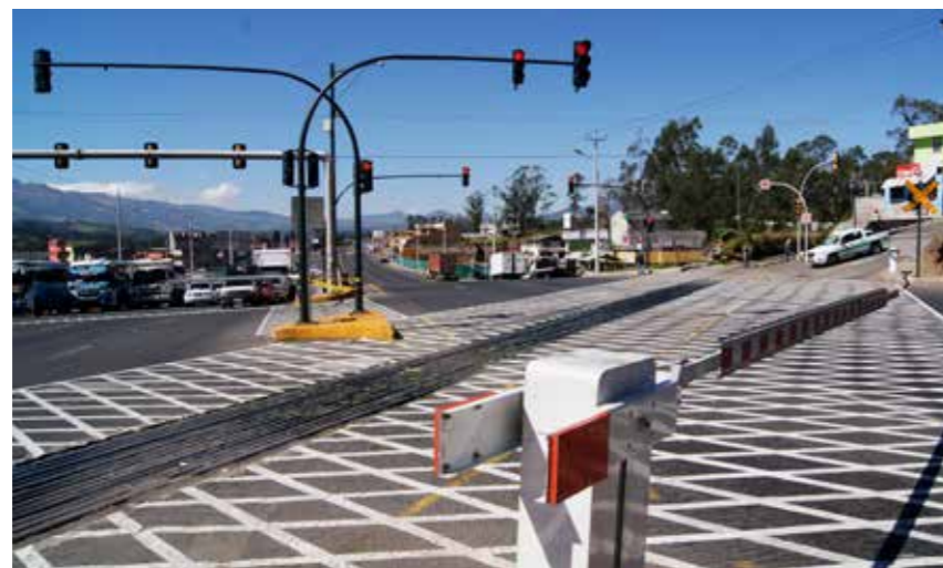
Foto 12 Sistema Integral de señalización Ferroviaria
