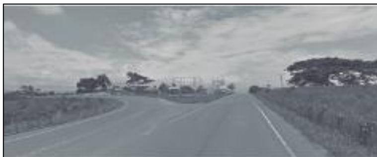
Vía E-15. Ingreso a la población de San José de Chamanga
