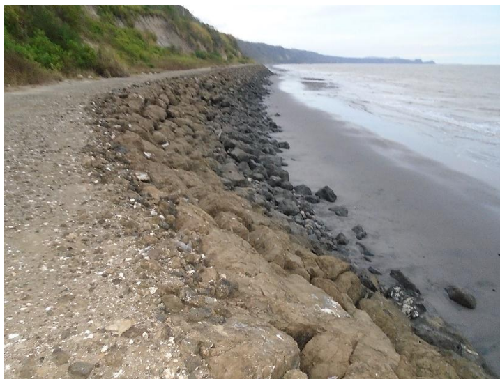
MURO DE ESCOLLERA EN SAN VICENTE DE CAMARONES
