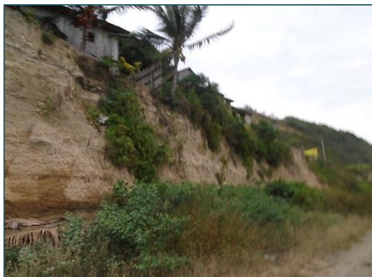
DESLIZAMIENTO DEL TALUD NATURAL POR IMPACTO DEL MAR
