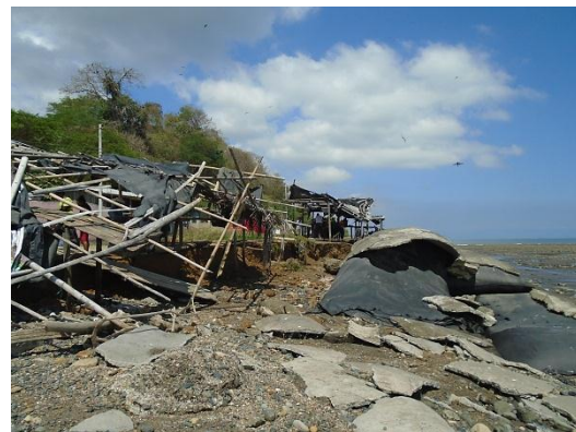
MURO DE GEOTEXTIL DESTRUIDO POR IMPACTO DEL MAR
