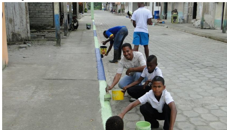
Foto18. Mantenimiento en la cabecera Parroquial
