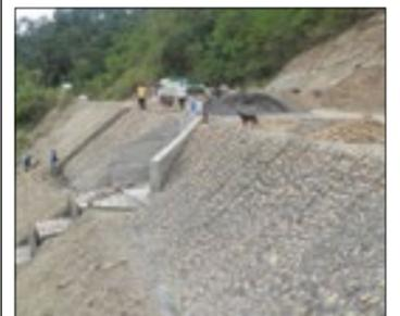
A través de obras emergentes la Prefectura ejecuta la instalación de alcantarillas con cabezales de hormigón en los puntos donde flujos de agua cortaban la circulación vehicular.
