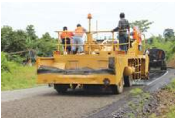
Asfaltado en doble tratamiento bituminoso de 5.2 Km desde la estatal al recinto Balsalito
