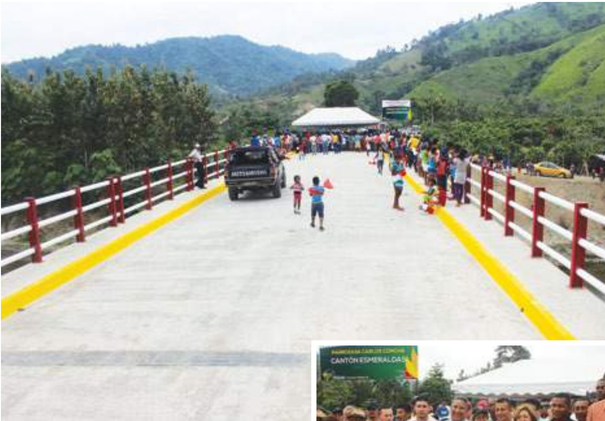
Puente sobre el río Huele de 50 metros lineales
