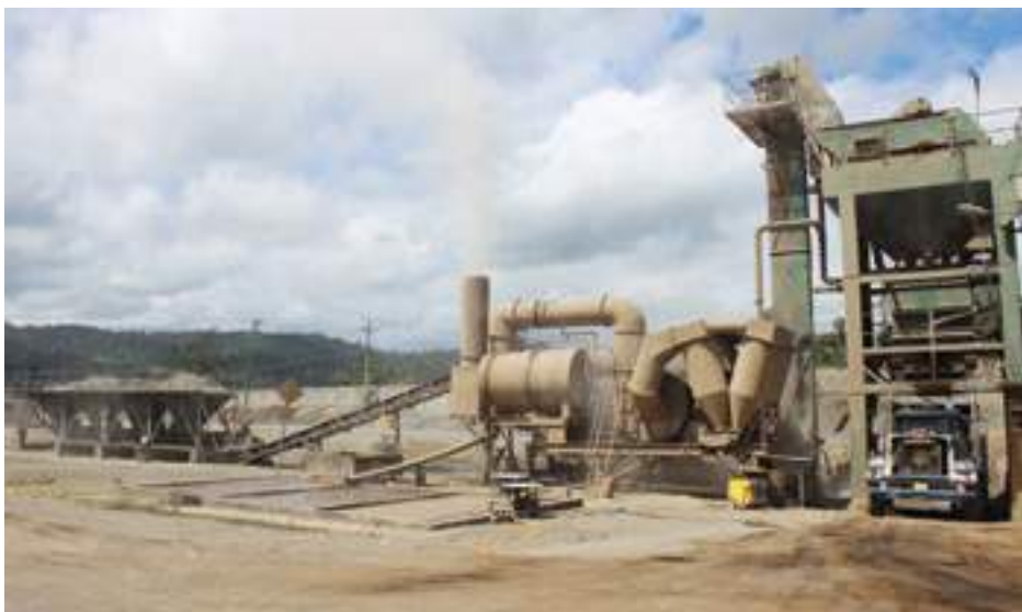
Planta asfáltica ubicada en San Mateo-Esmeraldas
