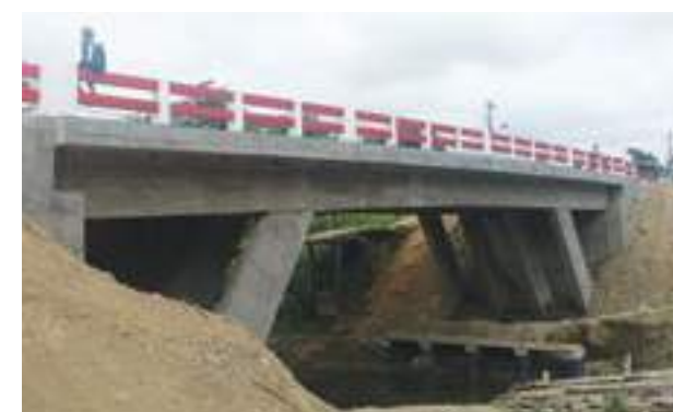
Hoy esta estructura vial cimienta el desarrollo de la comunidad
