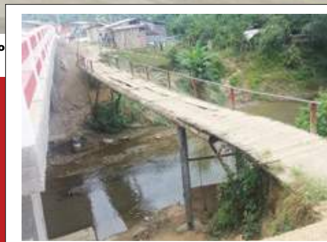
Antes. A través de este improvisado puente cruzaban el río
