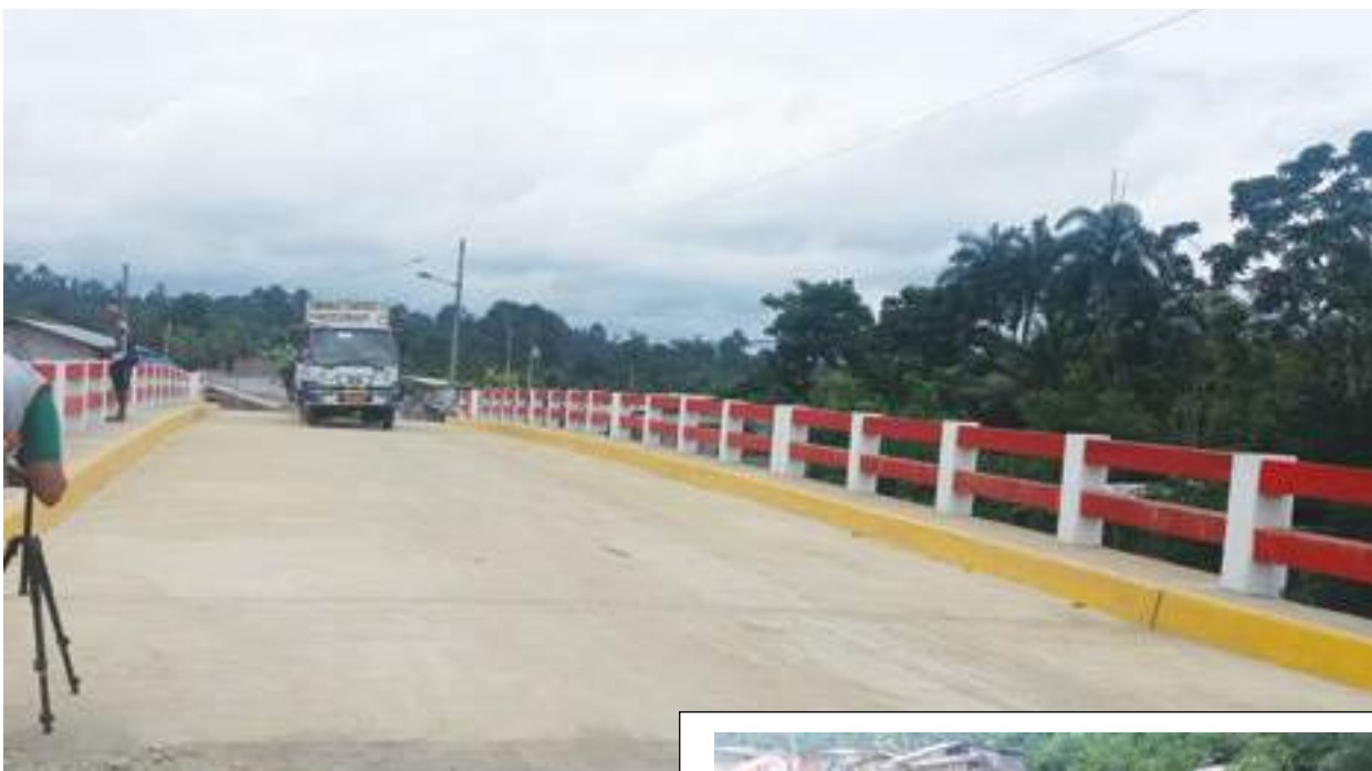
Puente sobre el río Muisne a la altura del recinto Balsalito parroquia San Gregorio
