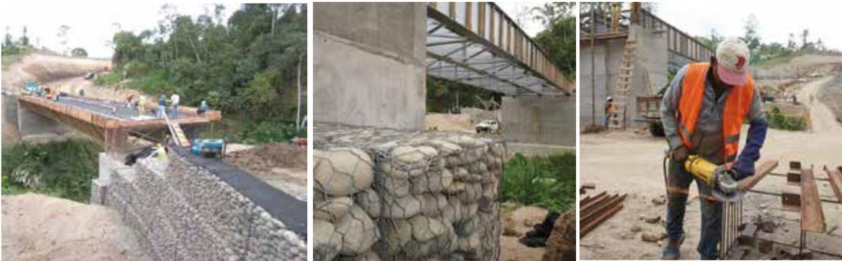
De igual manera, se construyeron 375 metros lineales de alcantarillas; 28 metros lineales de ductos cajón; 122 metros cúbicos de muros de gaviones con una inversión de más de 1 millón de dólares. De ellos, 153 metros lineales de alcantarillas metálicas se construyeron en Quinindé y 18 metros de ducto cajón. 60 metros lineales de alcantarillas metálicas y 24 metros cúbicos de gaviones en Rioverde.
